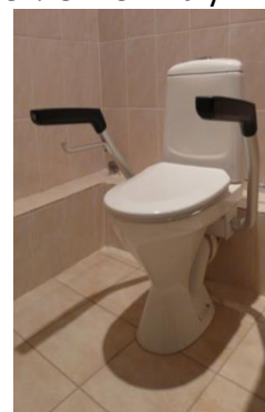
Откидные поручни с креплением на унитазе
