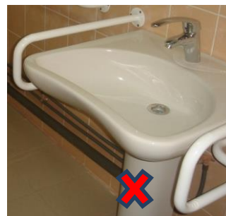
Допустимо размещать поручни только по бокам раковины
